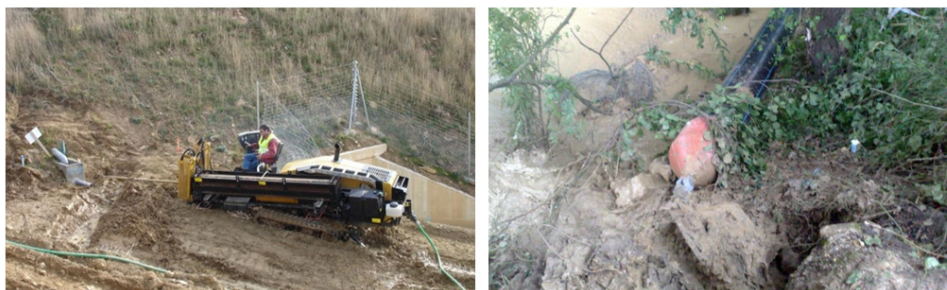
Figura 2: - Exemplo de uma máquina a perfurar e do início de traccionamento de uma tubagem em PEAD para dentro do furo.
